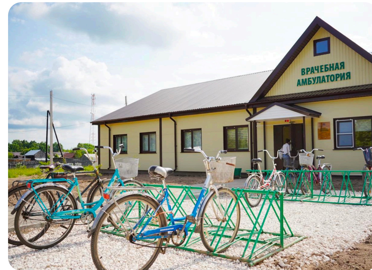
ВРАЧЕБНАЯ АМБУЛАТОРИЯ, ПОС. КОЛОБОВО (ШУЙСКИЙ РАЙОН, 2022)
